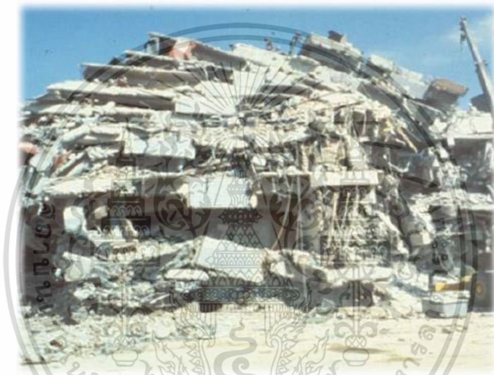
รูปที่ 2.14 การวิบัติของอาคารในลักษณะ progressive ที่ประเทศเม็กซิโก
