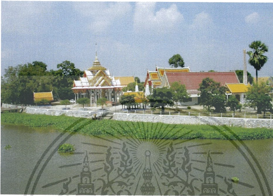
ภาพที่ 4.4-1 โครงสร้างปิดทับหน้าตลิ่งแบบเรียงหินใหญ่
