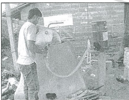
การติดตั้งหม้อต้มไอน้ำ
