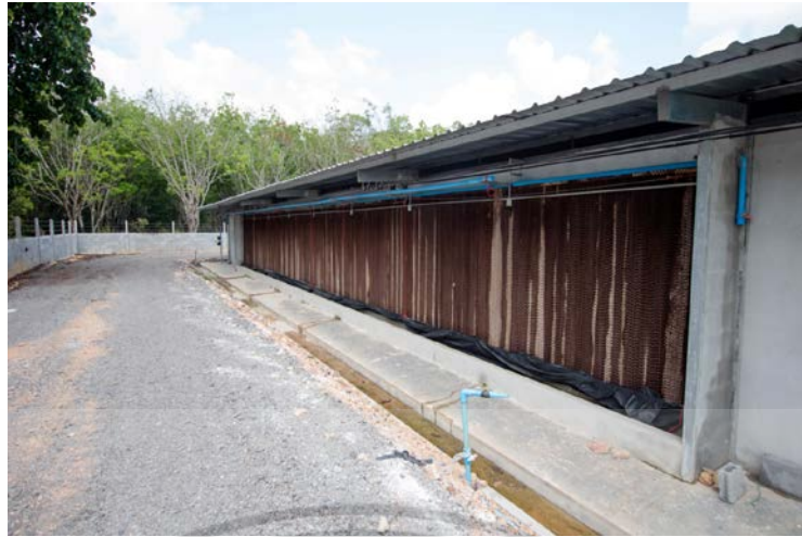
รูปที่ 3.8 รางระบายน้ำเสียภายใน สุพิศฟาร์ม
