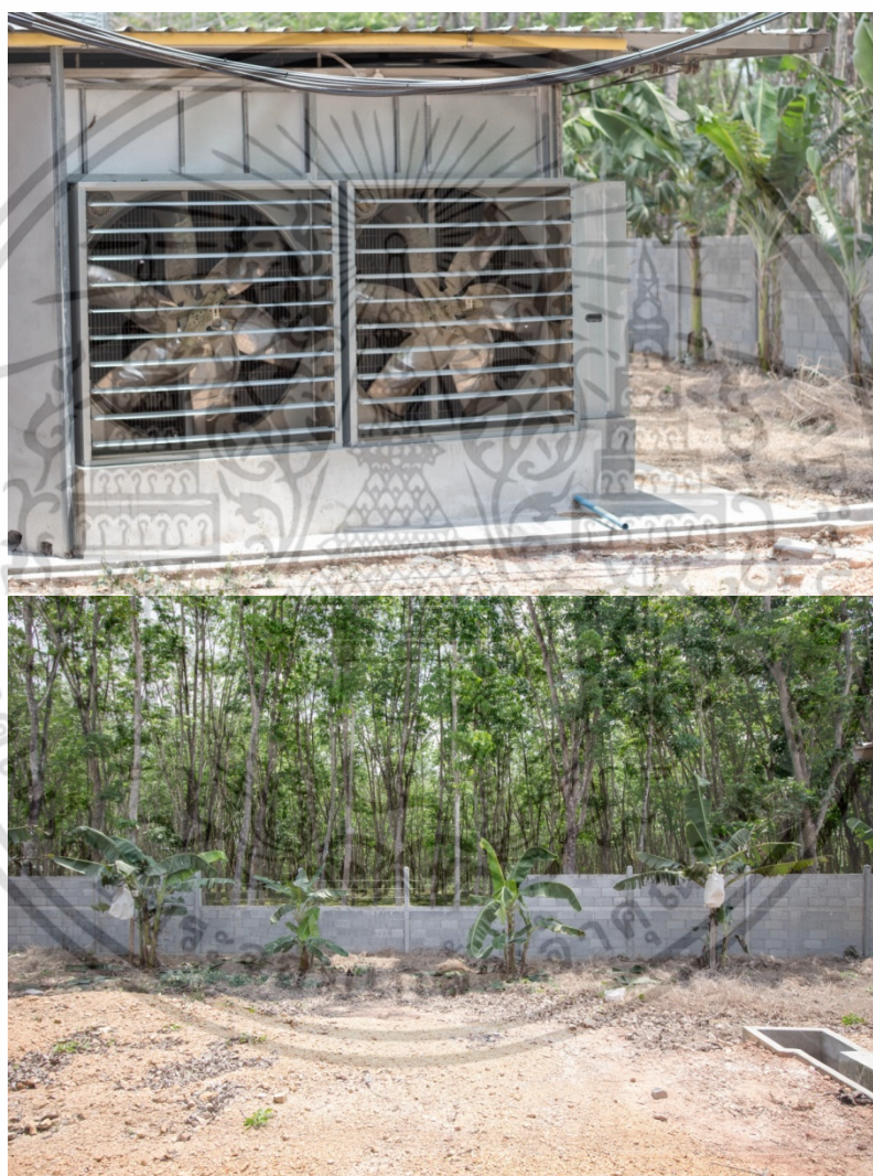
รูปที่ 4.1 ครอบฝุ่นละอองที่เกาะตามพัดลมระบายอากาศและแนวต้นกล้วยและสวนยางพาราที่คอยดับจับก๊าซและฝุ่นละอองที่ลอยออกมา
