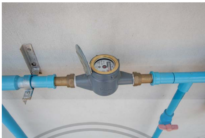
รูปที่ 3.3 มิเตอร์สำหรับเก็บค่าการใช้น้ำภายใน สุพิศฟาร์ม
