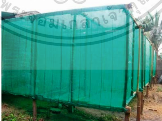
รูปที่ 2.13 ระบบบำบัดแบบม่านกระจายน้ำ (วิมลทิน แก้วทะนง)
