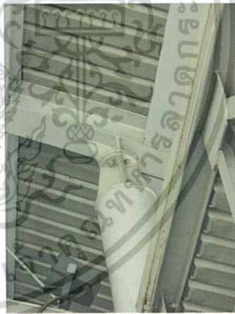
ภาพที่ 4.41 แสดงจุดต่อเสาและหลังคากระดับบนของโครงสร้างหลังคารูปแบบ B-04
