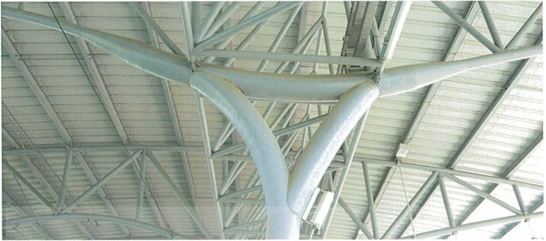
ภาพที่ 4.58 แสดง Lower chord ของ โครงสร้างหลังคาแบบ S-03
