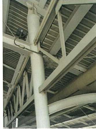
ภาพที่ 4.40 แสดงจุดต่อคานหลังคาระดับล่างของโครงสร้างหลังคารูปแบบ B-04
