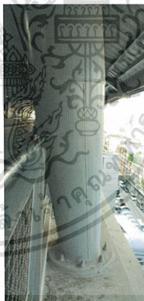
ภาพที่ 4.46 แสดงฐานรองรับเสาของ โครงสร้างหลังคารูปแบบ S-01
