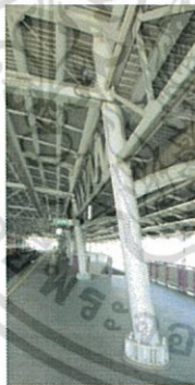
ภาพที่ 4.35 แสดงจุดต่อที่ฐานรองรับของ โครงสร้างหลังคารูปแบบ B-04
