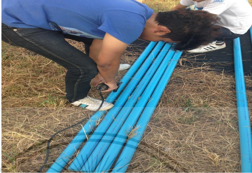
รูปที่ 3.6 การเตรียมท่อป่อสังเกตการณ์
