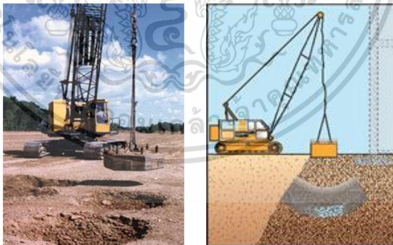
รูปที่ 2.9 การบดอัดดินแบบ Dynamic compaction
