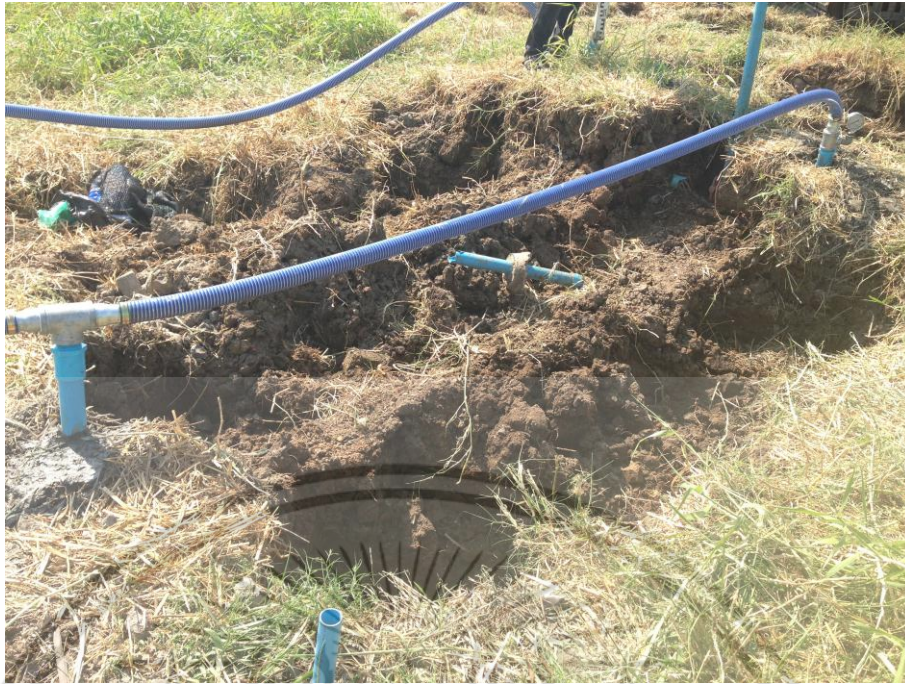
รูปที่ 3.22 สภาพหน้าดินหลังจากกระบวนการทุบอัดแบบไดนามิก
