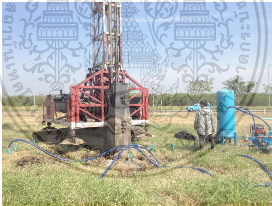
รูปที่ 3.21 กระบวนการทาบอัดแบบไดนามิก
