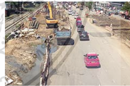
การทำงานก่อสร้าง
