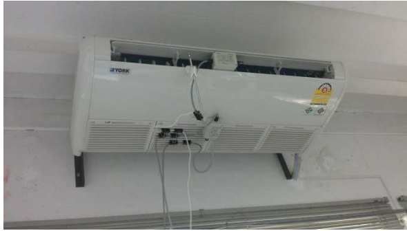
รูปที่ 4 การติดตั้งชุดหัววัดมีคอยล์เย็น
