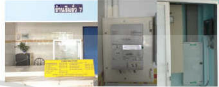
รูปที่ 6 การติดตั้งมิเตอร์ และ ดิจิยู
