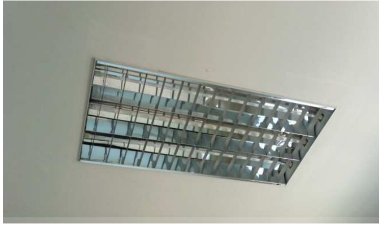
รูปที่ 3.25 โคมติดลอยตะแกรงถี่แผ่นสะท้อนแสงอลูมิเนียม 95% พร้อมหลอด Fluorescent 3X36
