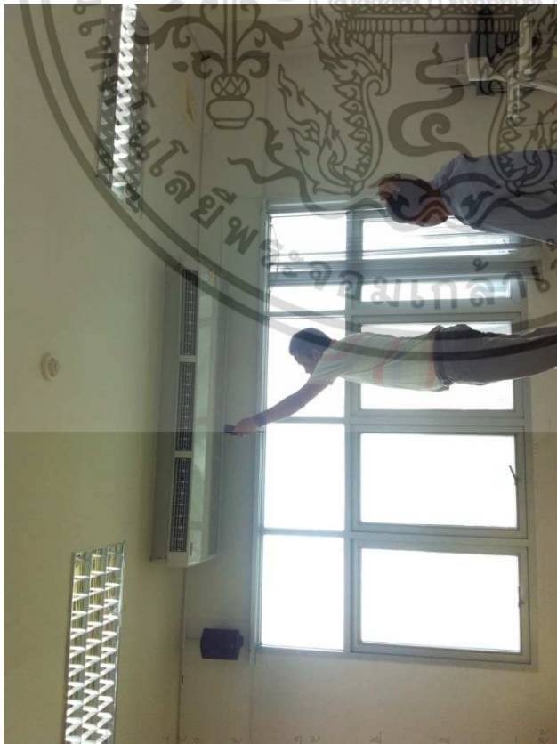
รูปที่ 4.1 การวัดค่าข้อมูลหาประสิทธิภาพเครื่องปรับอากาศแบบแยกส่วน
