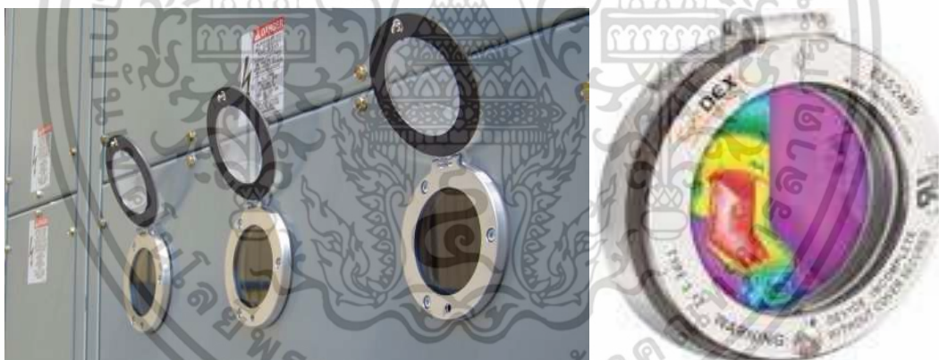
รูปที่ 2.1 การติดตั้งหน้าต่างอินฟราเรด
