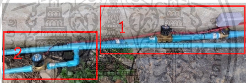
รูปที่ 3.23 การติดตั้งโซลินอยด์วาล์วและโฟลว์สวิทช์
