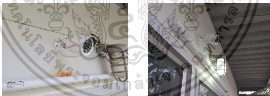
รูปที่ 3.25 การติดตั้งไอพีแคมบริเวณแปลงเพาะปลูก
