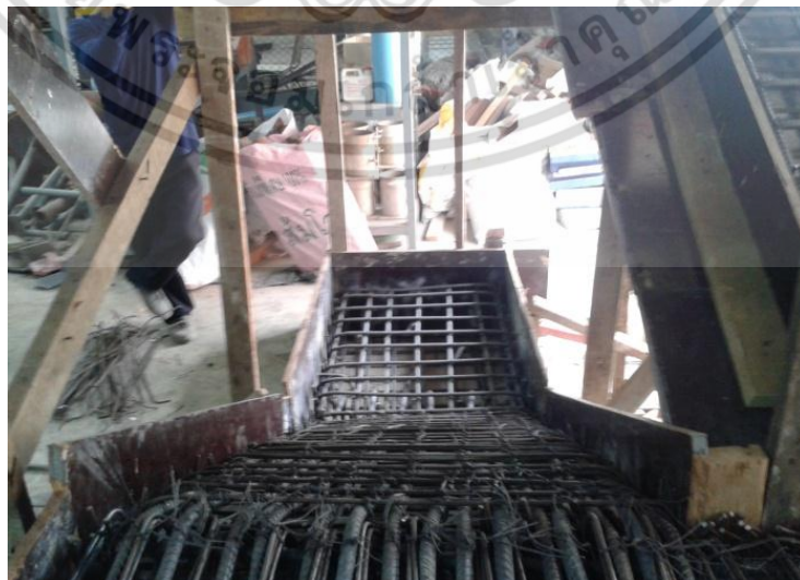
รูปที่ 3.32 ลักษณะการปิดแบบข้าง เพื่อเตรียมการเทคอนกรีตบันไดทดสอบ
