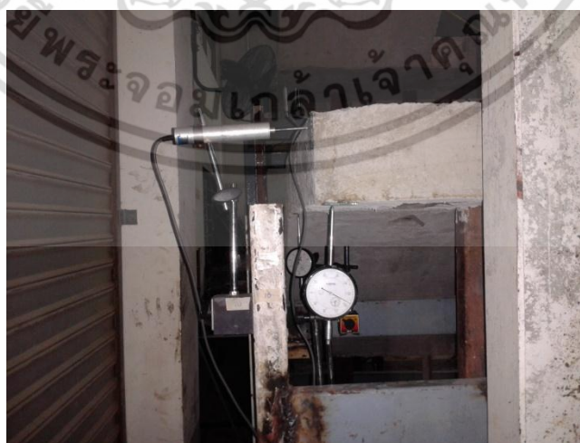
รูปที่ 3.44 ติดตั้ง Dial Gauge บริเวณขอบด้านข้างชานพัก 1 จุด
