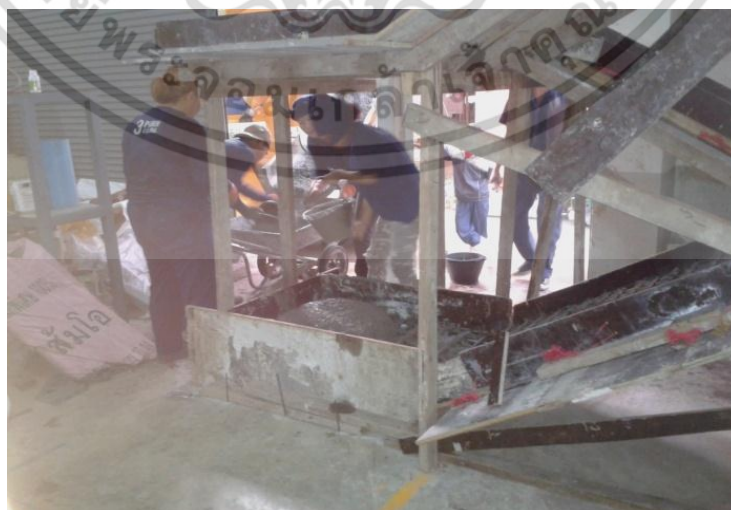
รูปที่ 3.36 ลักษณะการเทคอนกรีตของบันไดทดสอบ
