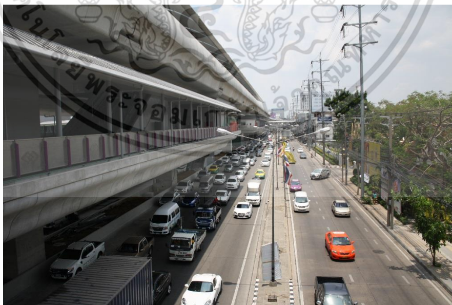
รูปที่ 4.5 ถนนรัตนวิเบศร์ฝั่งศูนย์ราชการจังหวัดนนทบุรี
