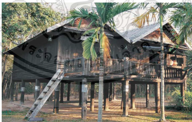
รูปที่ 2.3 แสดงลักษณะเรือนแฝดมีเรือนโข่ง
