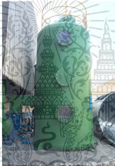
รูปที่ 4.10 แสดงระบบไปไอสครับเบอร์ขนาด 108 ลูกบาศก์เมตรต่อนาที
