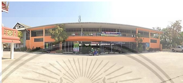
ภาพที่ 4.158 แสดงอาคารเรียนระดับอนุบาล 1-2
