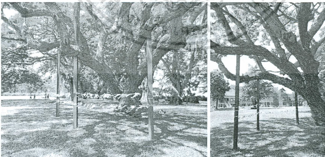
ภาพที่ 4.8 การติดตั้งค้ำยันเพื่อรับน้ำหนักต้นจามจุรีบริเวณ F-03
