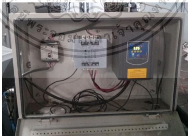
รูปที่ 5.18 อินเวอร์เตอร์คอนโทรลความเร็วรอบของมอเตอร์
