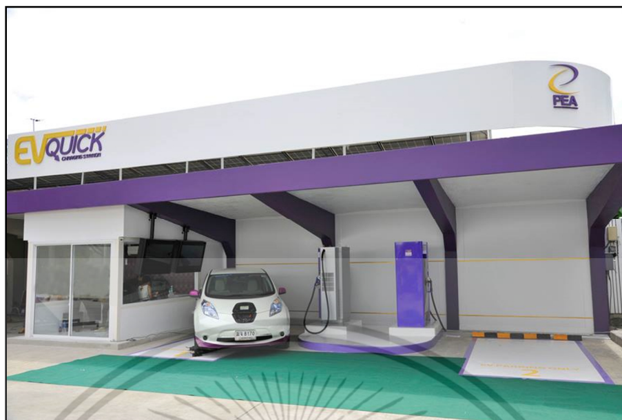
รูปที่ 4.17 ต้นแบบสถานีอัดประจุแบตเตอรี่แบบรวดเร็วมาตรฐาน CHAdeMO ของ กฟผ.
