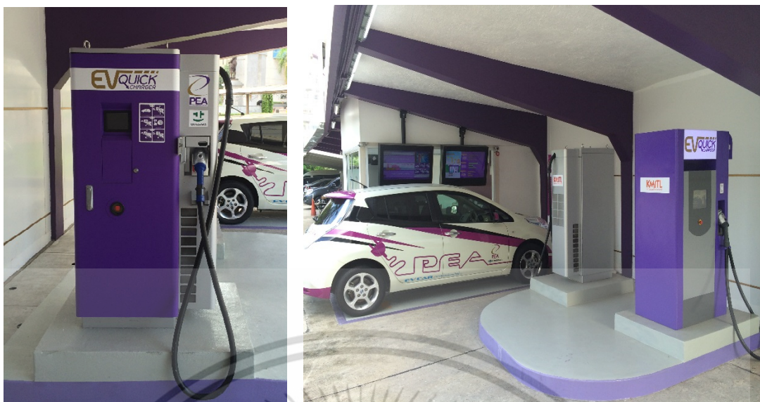
รูปที่ 3.4 ลักษณะเครื่องอัดประจุแบตเตอรี่แบบรวดเร็วตามมาตรฐาน CHAdeMO
