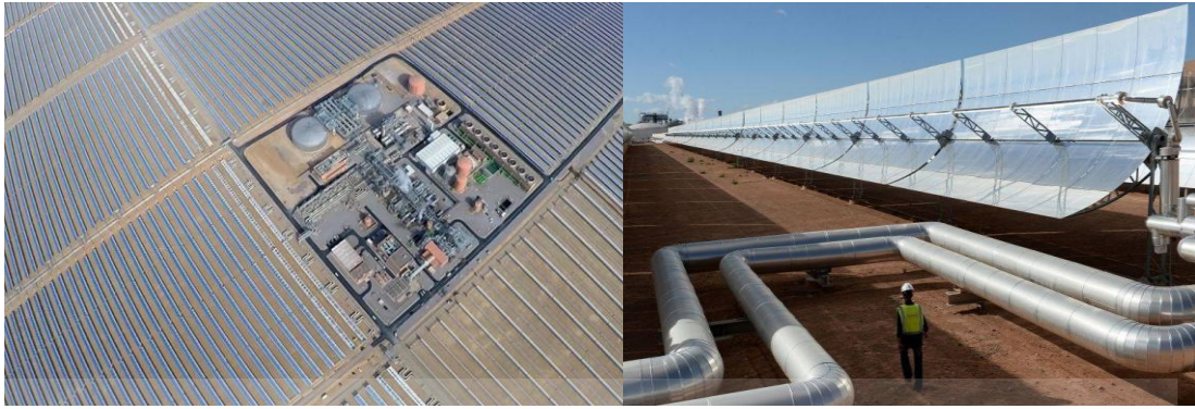
รูปที่ 2.17 โรงไฟฟ้า Ouarzazate Solar Power Station [10]
