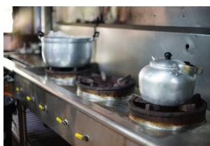
รูปที่ 2.7 เตาแก๊สแบบฝังติดตั้งกับเฟอร์นิเจอร์ของห้องครัว
