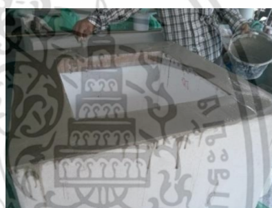
รูปที่ 3.10 แสดงขั้นตอนการฉาบปูน
