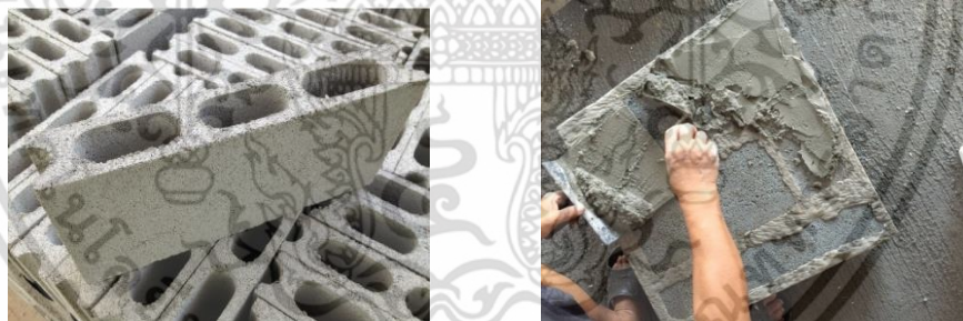
รูปที่ 3.14 ผนังก่ออิฐบล็อก
