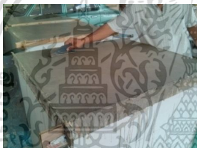
รูปที่ 3.10 แสดงขั้นตอนการฉาบปูน
