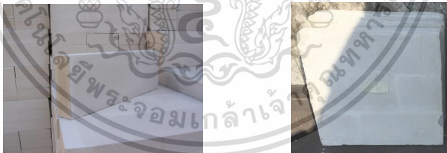
รูปที่ 3.16 ผนังก่ออิฐมวลเบา
