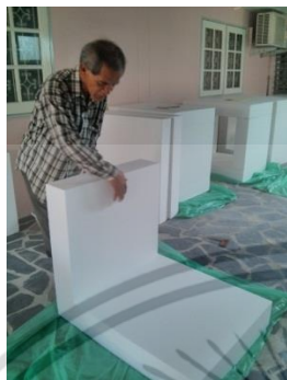
รูปที่ 3.6 แสดงการจัดวางโฟมให้ตรงตำแหน่งที่จะทากาว
