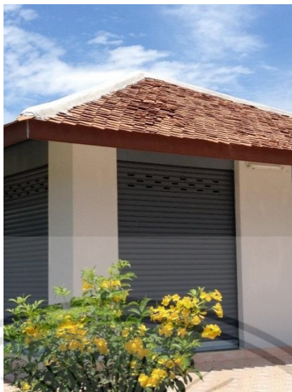
รูปที่ 4.27 ลักษณะหลังคาที่ก่อสร้างโดยใช้กระเบื้องดินเผาสมัยใหม่
