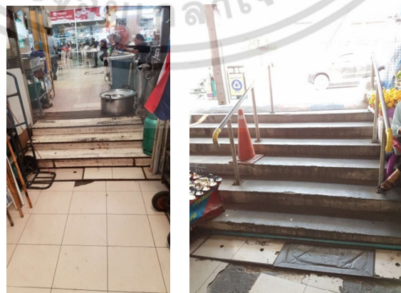
รูปที่ 4.8 ลักษณะบันไดภายในตลาดสดขี้เจี๊ยง
