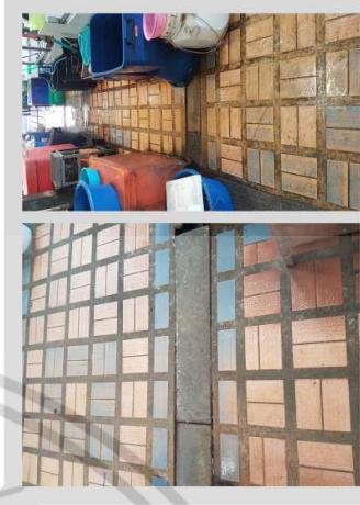
น้ำท่อระบายน้ำภายในตลาดสดเอี่ยมสมบัติ
