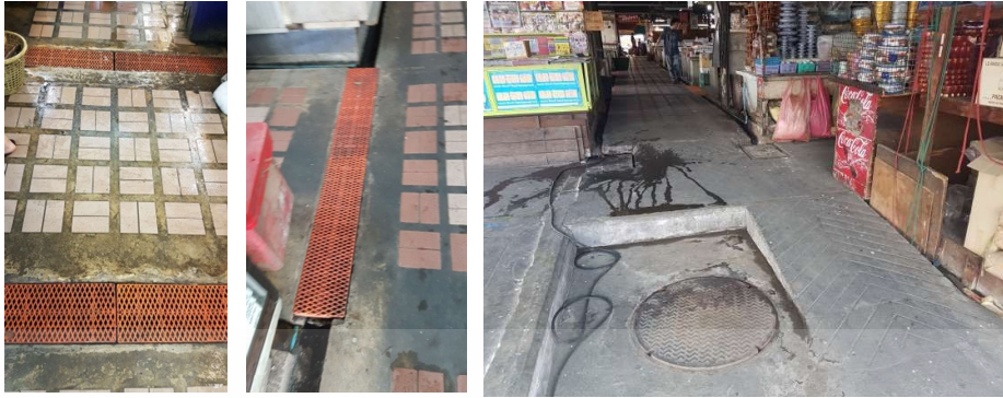
รูปที่ 4.68 ลักษณะฝาปิดช่องระบายน้ำและท่อระบายน้ำของตลาดสดแฮปปี้แลนด์
