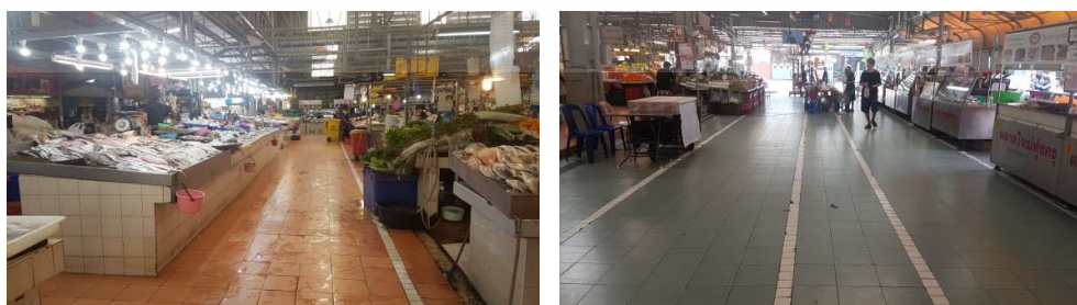
รูปที่ 4.90 ลักษณะพื้นบริเวณทางเดินของตลาดสดใหม่ทุ้งครุ
