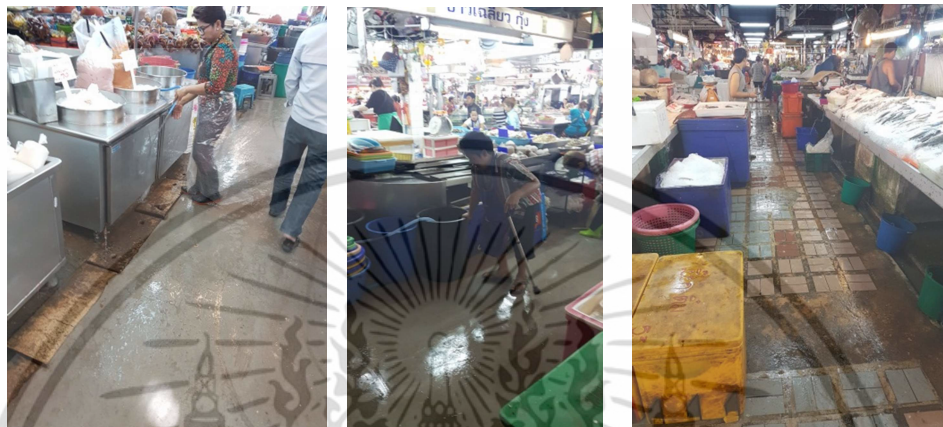
รูปที่ 4.103. ลักษณะพื้นที่ลื่นและเปียกและภายในตลาดสดกรณีศึกษา
