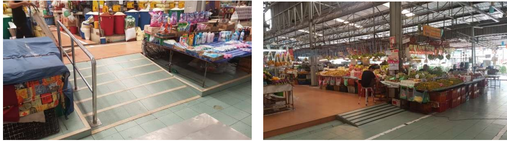
รูปที่ 4.91 ลักษณะทางลาดของตลาดสดใหม่ทุ่งครุ
