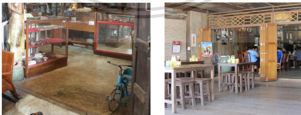
ภาพที่ 4.27 รูปแบบของพื้นปูนขัดมันและพื้นไม้
