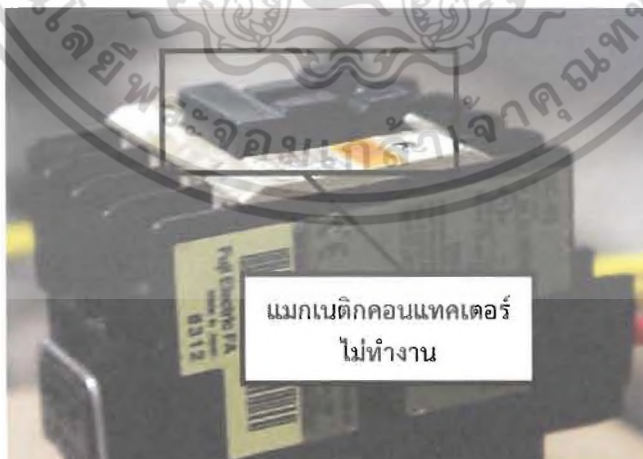
รูปที่ 4.23 เมื่อไม่มีกระแสไหลผ่านแมกเนติกคอนแทคเตอร์
