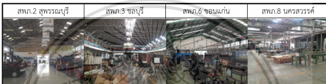
ภาพที่ 4.8 แสดงลักษณะภายในอาคารโรงฝึกงานของสถาบันพัฒนาฝีมือแรงงานภาค ที่ ๓ : จากการสำรวจเดือนกันยายน 2558
