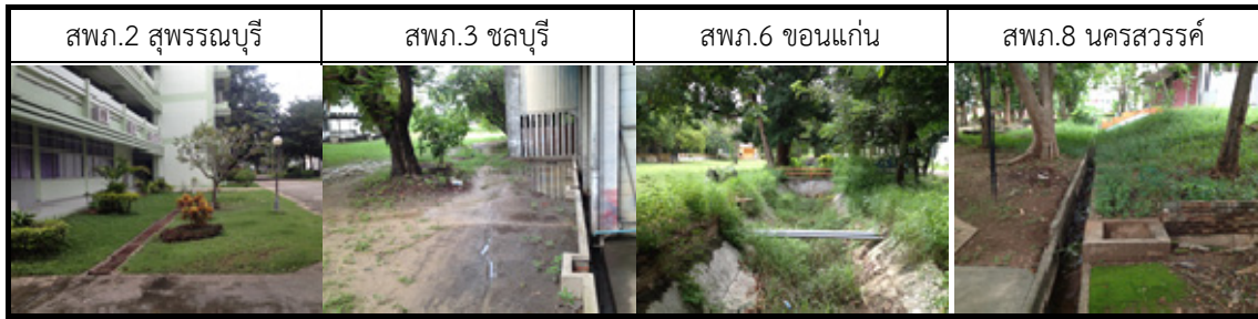
ภาพที่ 4.18 แสดงลักษณะระบบรางระบายน้ำแบบรางเปิด ที่มา : จากการสำรวจเดือนกันยายน 2558
