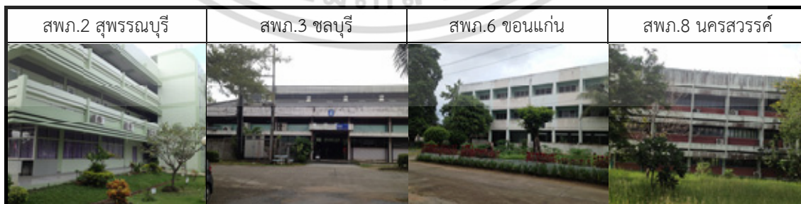
ภาพที่ 4.9 แสดงลักษณะอาคารเรียนรวมของสถาบันพัฒนาฝีมือแรงงานภาค ที่ ๓ : จากการสำรวจเดือนกันยายน 2558
