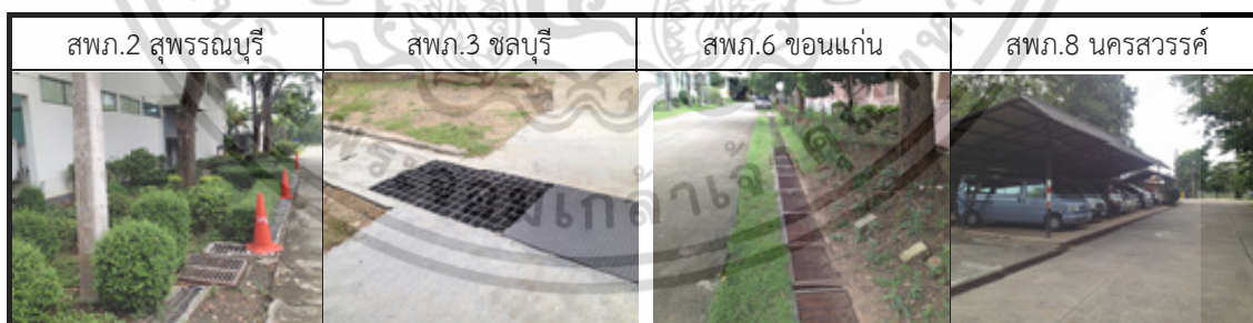
ภาพที่ 4.17 แสดงลักษณะระบบรางระบายน้ำแบบมีตะแกรงเหล็กปิด ที่มา : จากการสำรวจเดือนกันยายน 2558
