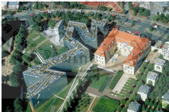
รูปที่ 2.31 แสดงรูปทรงภายนอกของอาคาร
