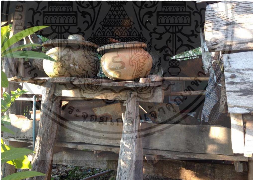
ภาพที่ ค.2 ส่วนชานหม้อน้ำ ของเรือนไทยภาคอีสาน
