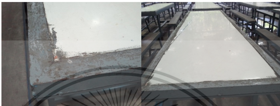
ภาพที่ 2.7 มุมโถ้ที่เป็นแหล่งสะสมของคราบสกปรก เชื้อโรค และการเกิดสนิม ที่มา: (ภัทรียา จิตตา คำ. 2556)
