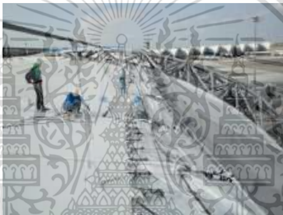
รูปภาพที่ 2.6 ตัวอย่างการใช้งานผ้าใยประเภท PTFE Coated Glass Fiber
