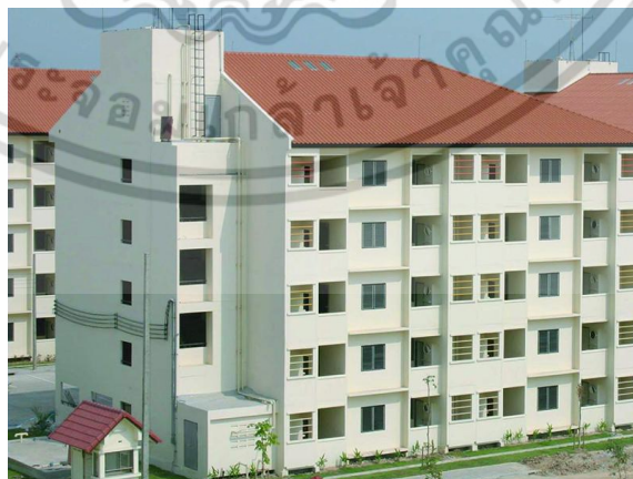
ภาพที่ 1.1-2 ภาพห้องชุด 5 ชั้น โครงการบ้านเอื้ออาทรปทุมธานี (บางคูวัด)
