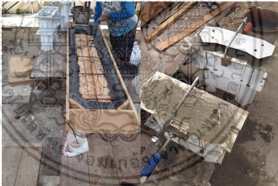
ภาพที่ 4.10 ภาพถ่ายขั้นตอนการหล่อต้นแบบ
