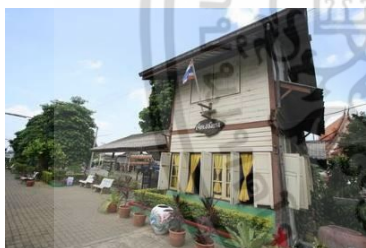
อาคารสถานีรถไฟเจ็ดเสมียนก่อนถูกรื้อ (ภาพจาก www.chetsamian.go.th )
