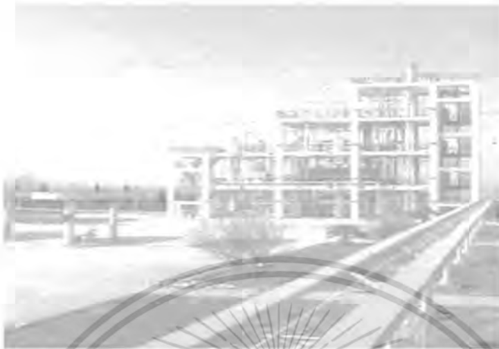
รูปที่ 4 โรงงานผลิตโดเมทิลอีเทอร์จากแก๊สสังเคราะห์ที่ได้จากถ่านหิน ในประเทศจีนกำลังการผลิต 8000 เมตริกตันต่อปี [6-7]
