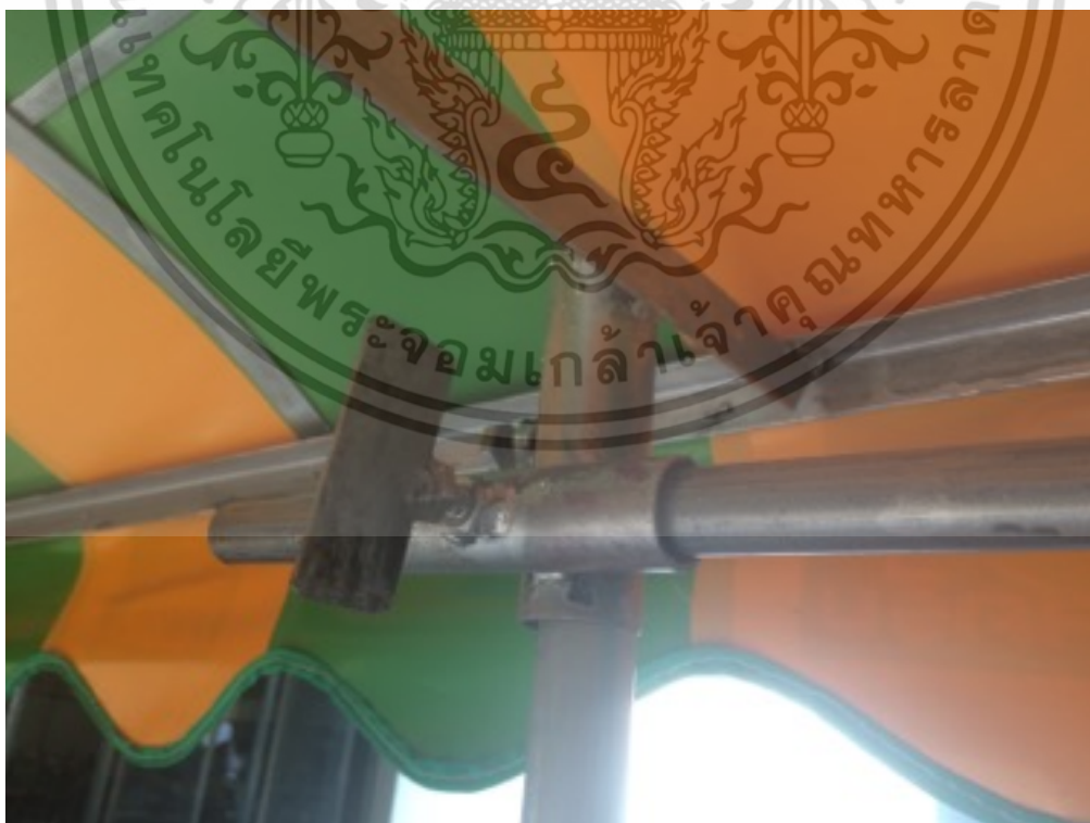
ภาพที่ 4.7 ข้อต่อโครงหลังคาส่วนกันสาด
