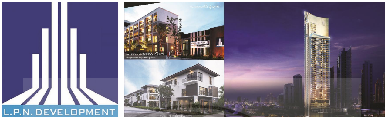
ภาพที่ 2.4-5 แสดงลักษณะอาคารในโครงการลุมพินี
