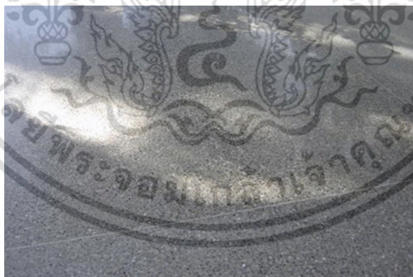
รูปที่ 2.51 พื้นคอนกรีตหินขัด
