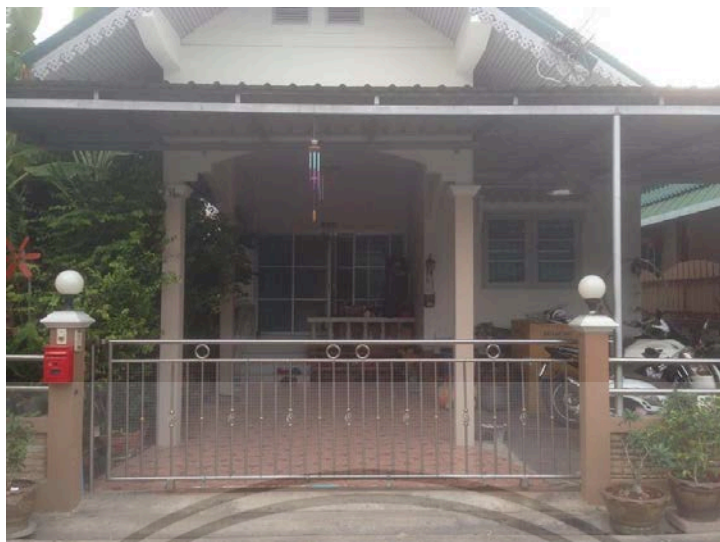
รูปที่ 2.54 รูปบริเวณโรงจอดรถหน้าบ้าน
