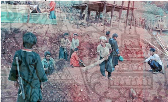
รูปที่ 2.8 ภาพแสดงการซ่อมแซมลานจะคี่
