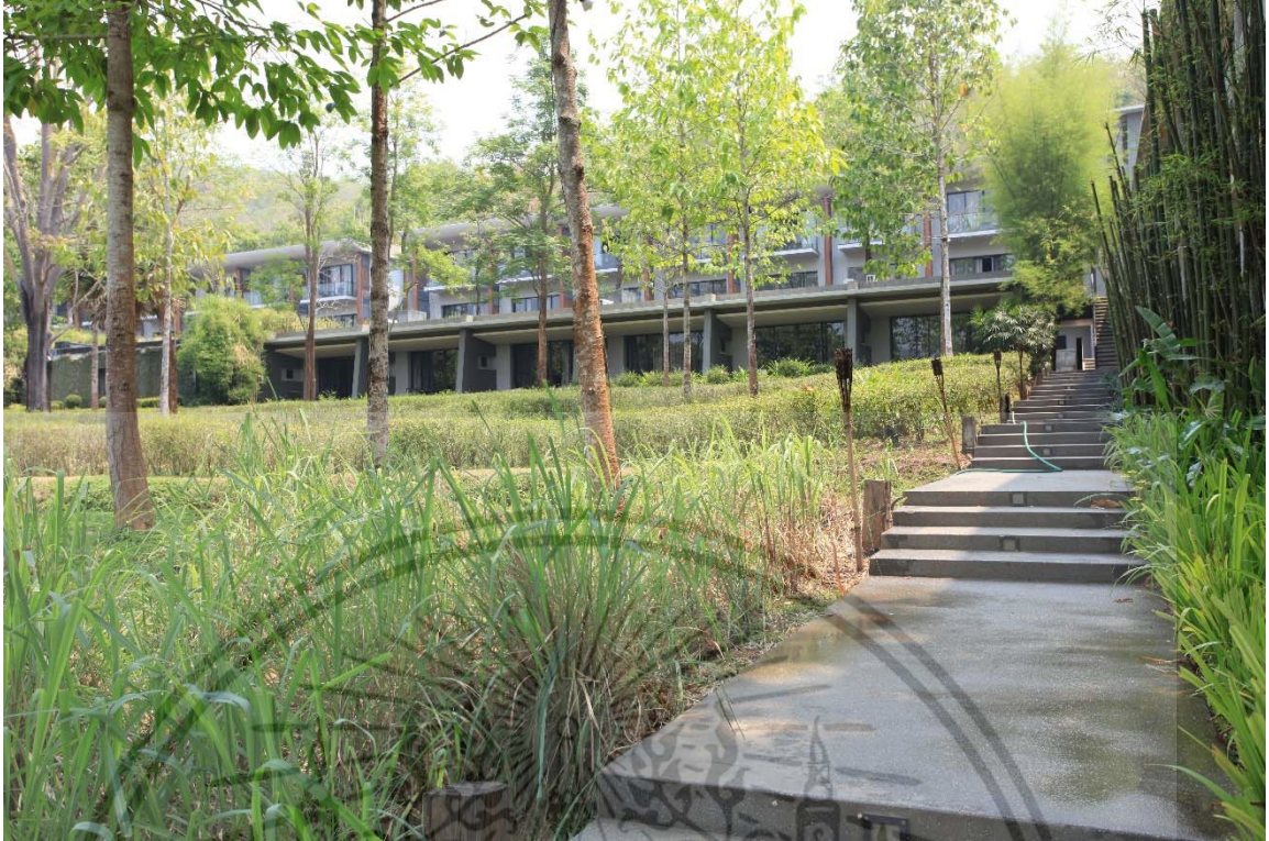
รูปภาพที่ 1.6 6 อาคารห้องพัก
