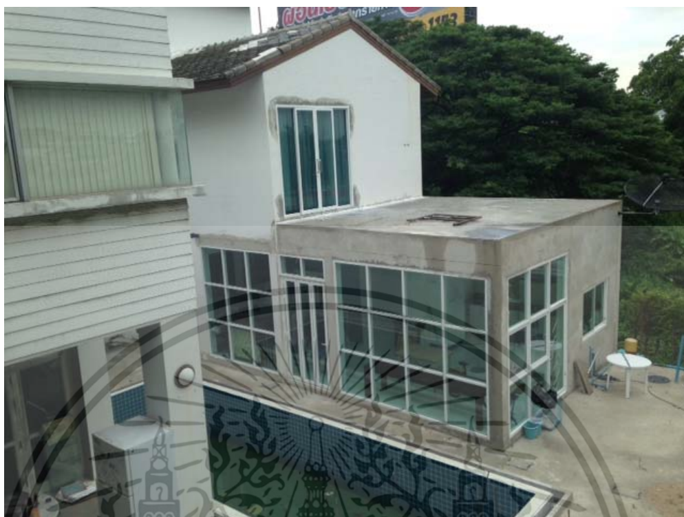
ภาพที่4.8 ภาพจากชั้น2 ของส่วนที่ต่อเติมของ Building A มองไปทาง Building B -Building C เป็นอาคารที่กำลังอยู่ในระหว่างการก่อสร้าง ยังไม่แล้วเสร็จ มีทั้งหมด5ชั้นรวมชั้นดาดฟ้า มี พื้นที่ 1693.9 ตารางเมตร -สภาพปัจจุบัน
