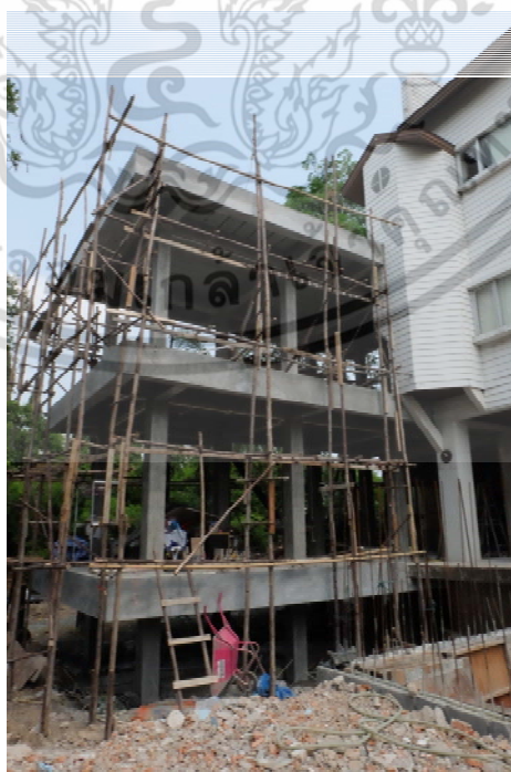
ภาพที่1.6 ส่วนที่กำลังต่อเติมของ Building A
