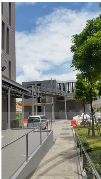
รูปที่ 1.15 พื้นที่ด้านหลังอาคาร
