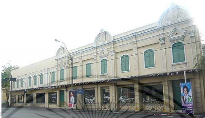
ลักษณะอาคารตึกที่ 1
