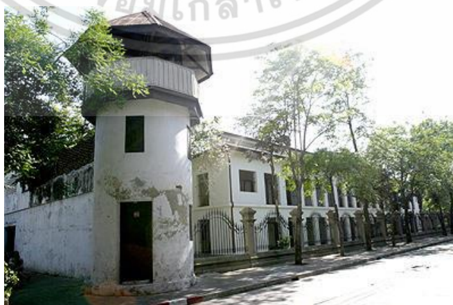
ลักษณะอาคารตึกที่ 3
