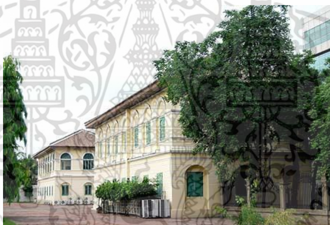
ลักษณะอาคารตึกที่ 2
