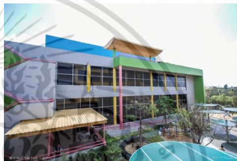
ภาพที่ 10 ลักษณะอาคาร
