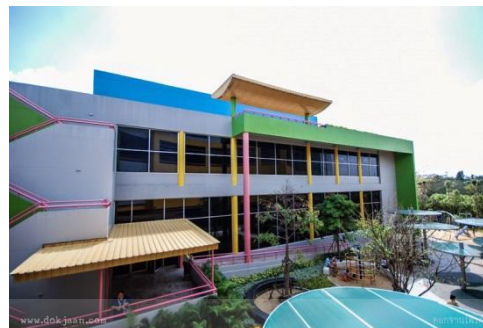
ภาพที่ 53 ลักษณะอาคาร
