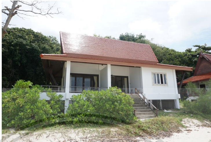
ภาพที่ 20 ด้านหน้าอาคารที่พัก
