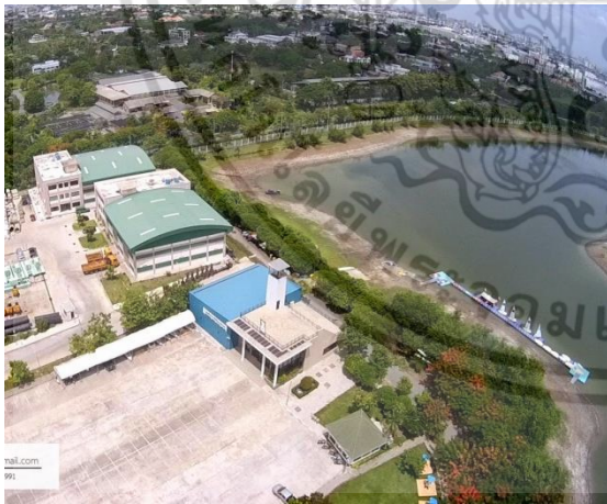
รูปภาพ 08 แสดงภาพมุมสูงของอาคารหลักที่ติดกับบึงรับน้ำ
