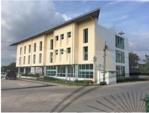
รูปภาพ10 อาคารที่กำลังสร้างใหม่แสดง
