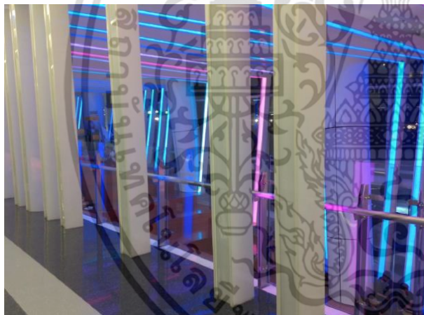
ภาพที่ ๖ ไฟ LED ภายในอาคาร
