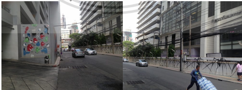
ภาพที่1.6แสดงสภาพแวดล้อมรอบอาคารในทิศใต้ ทิศใต้ ติดกับถนนสายย่อยในซอยจุฬาลงกรณ์ 64 ตรงข้ามกับตึกคณะทันตแพทย์ เอกสารนี้เป็นเอกสารที่สงวนไว้สำหรับการใช้งานเพื่อการศึกษาเท่านั้น ไม่อนุญาตให้นำไปใช้ประโยชน์ด้านการค้า ไม่ว่ากรณีใดๆ ทั้งสิ้น อีกทั้งห้ามมิให้ตัดแปลงเนื้อหา และต้องอ้างอิงถึงเจ้าของเอกสารทุกครั้งที่มีการนำไปใช้
