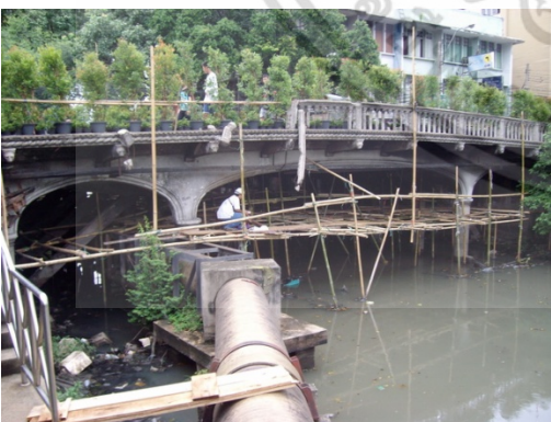
รูปที่ 3: สะพานพิทยเสถียร
